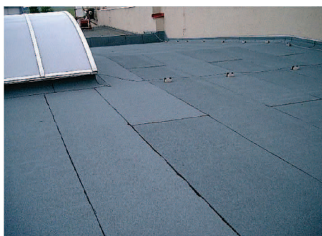
Obr. B1 Pohled na stejnou partii střechy z různých směrů – odstín asfaltového pásu se mění podle směru pohledu. Na obrázku vlevo jsou pásy u světlíku tmavší, na obrázku vpravo je stejná oblast při pohledu z jiného úhlu světlejší. Zdroj: [vlastní]
