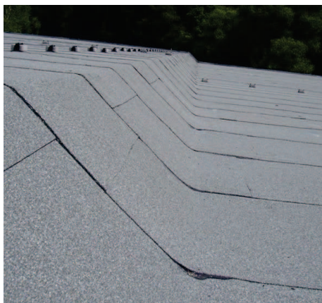
Obrázek F 01, 02 Na svislé a šikmé plochy se volí asfaltové pásy se zvýšenou odolností proti stékání asfaltové krycí hmoty. Zdroj: [vlastní].
