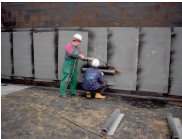
Obr. D 03 Natavování asfaltového pásu na stěnu spodní stavby – pás se natavuje z krátkého návinu role, ze zdola nahoru, ve dvou lidech. Zdroj: [vlastní].
