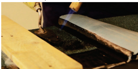
Obr. D 04 Nahřátí povrchu a zatlačení drčené břidlice do asfaltové hmoty.
