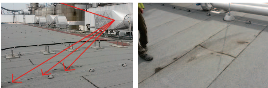
Obrázek F 05, 06 Působení odrazivé plochy na střešní plášť. Zdroj: [vlastní].
