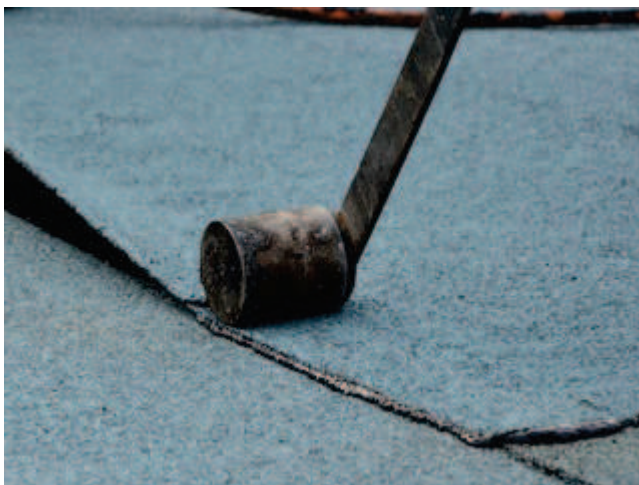
Obr. D 01 Návalek asfaltové krycí hmoty v podélném i příčném přesahu asfaltového pásu. Zdroj: [vlastní].
