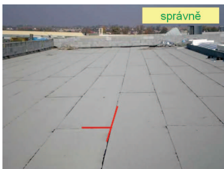
Obr. D 06 Spoje tvaru T – správně.
