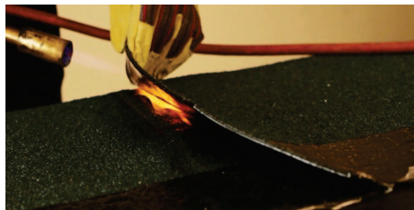
Obr. D 05 Natavení příčného přesahu.
