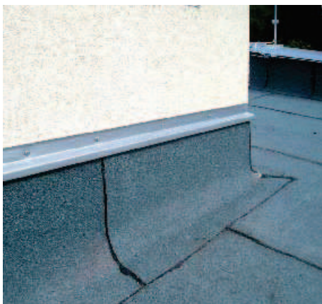
Obrázek F 01, 02 Na svislé a šikmé plochy se volí asfaltové pásy se zvýšenou odolností proti stékání asfaltové krycí hmoty. Zdroj: [vlastní].
