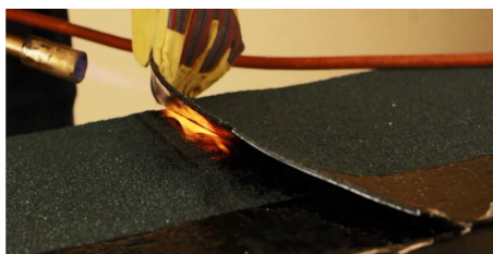
Obr. 29 Natavení příčného přesahu. Zdroj: [vlastní].
