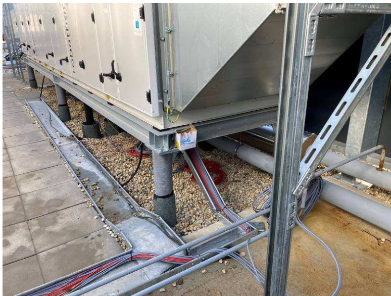
Obr. 21 Příklad zpracování podpěr technologie asfaltovým pásem Zdroj: [vlastní].
