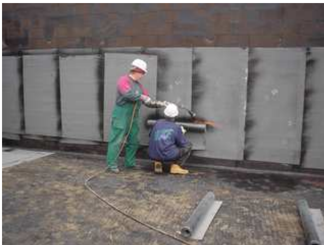
Obr. 27 Natavování asfaltového pásu na stěnu spodní stavby – pás se natavuje z krátkého náviny role, ze zdola nahoru, ve dvou lidech. Zdroj: [vlastní].
