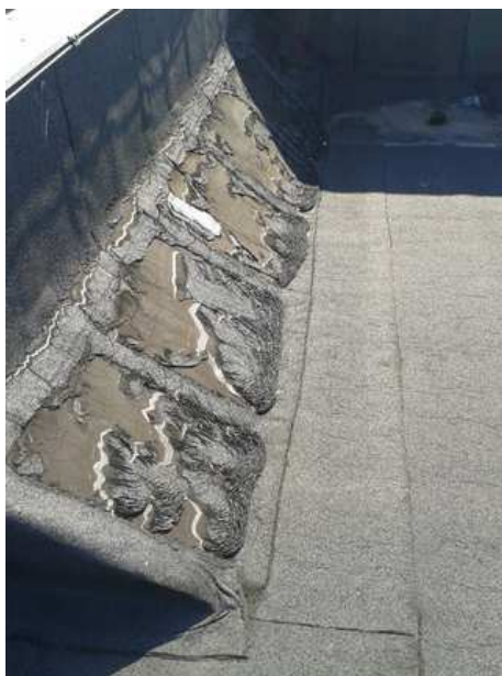
Obrázek F 03 Asfaltová hmota stekla téměř zcela na šikmých plochách atiky orientovaných na JZ, na svislé ploše atiky se asfalt udržel. Zdroj: [vlastní].
