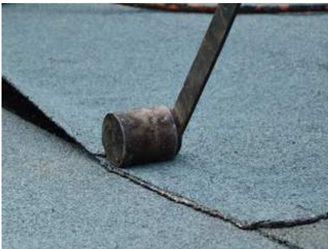
Obr. 25 Návalek asfaltové krycí hmoty v podélném i příčném přesahu asfaltového pásu. Zdroj: [vlastní].
