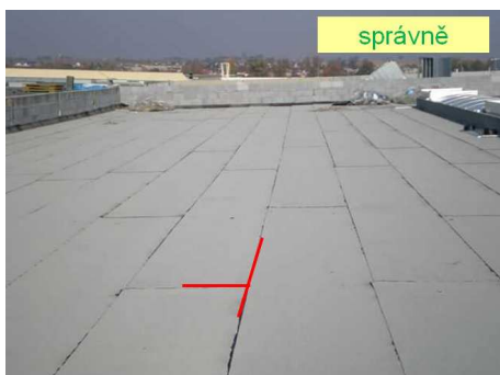
Obr. 30 Spoje tvaru T – správně. Zdroj: [vlastní].
