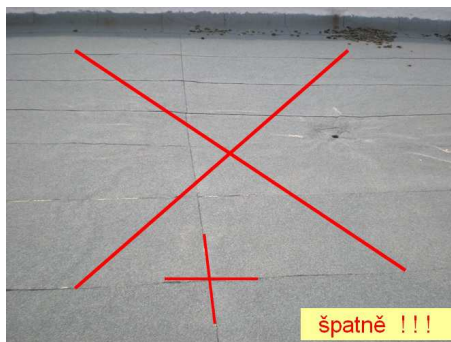
Obr. 31 Spoje tvaru X - špatně Zdroj: [vlastní].
