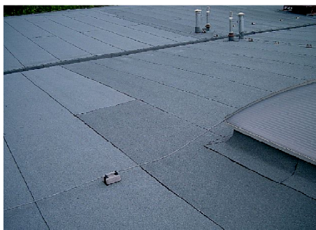
Obr. B01 Pohled na stejnou partii střechy z různých směrů – odstín asfaltového pásu se mění podle směru pohledu. Na obrázku vlevo jsou pásy u světélku tmavší, na obrázku vpravo je stejná oblast při pohledu z jiného úhlu světlejší. Zdroj: [vlastní]
