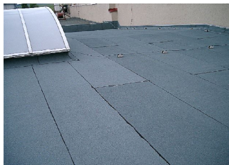
Obr. B01 Pohled na stejnou partii střechy z různých směrů – odstín asfaltového pásu se mění podle směru pohledu. Na obrázku vlevo jsou pásy u světélku tmavší, na obrázku vpravo je stejná oblast při pohledu z jiného úhlu světlejší. Zdroj: [vlastní]
